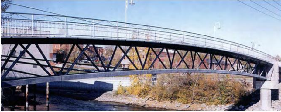
カナダ・シャープブルックの歩道橋 (1997)
