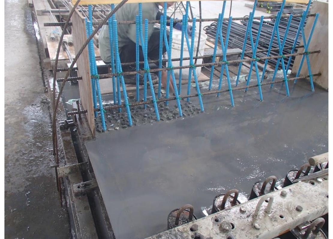
打継目処理(粗骨材散布)
