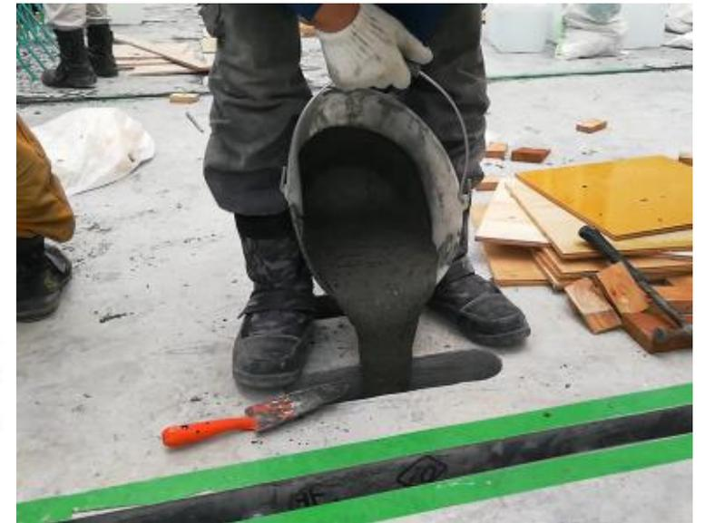
写真 間詰めUHPFRCの打込み
