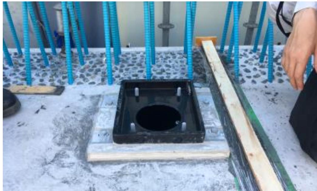
写真 壁高欄・排水マス設置部
