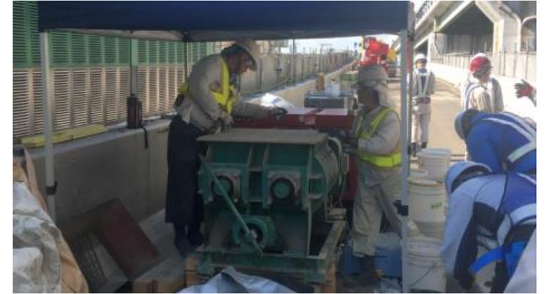
写真 間詰めUHPFRCの練り混ぜ状況
