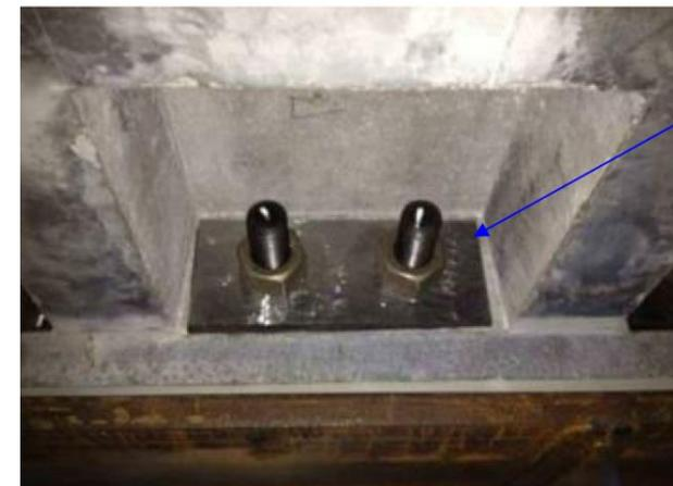
定着板を傾斜面に合わせてテーパに製作する。
