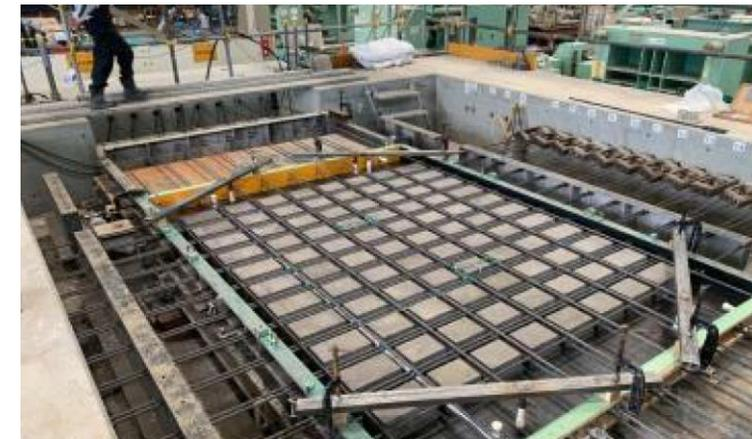
写真 ワッフル型UFC床版の型枠
