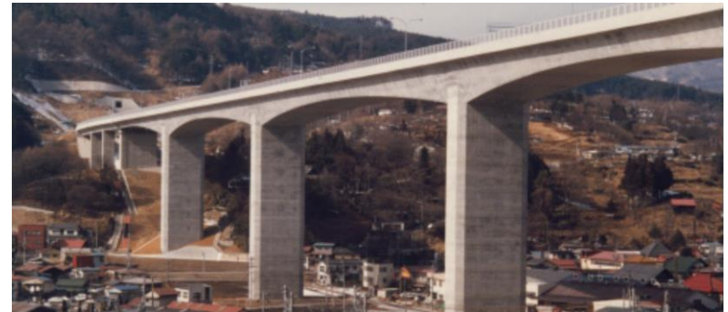
岡谷高架橋改良工事(鹿島建設)
